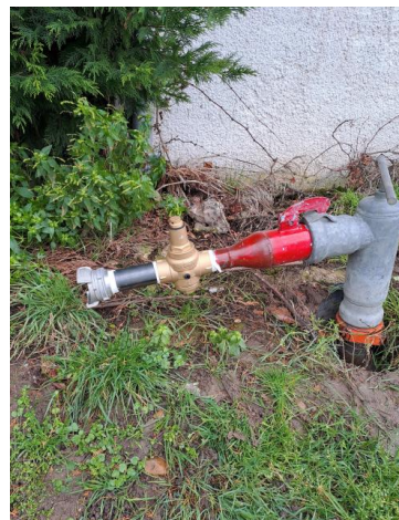
Forage avec demi-raccord de 65 mm
