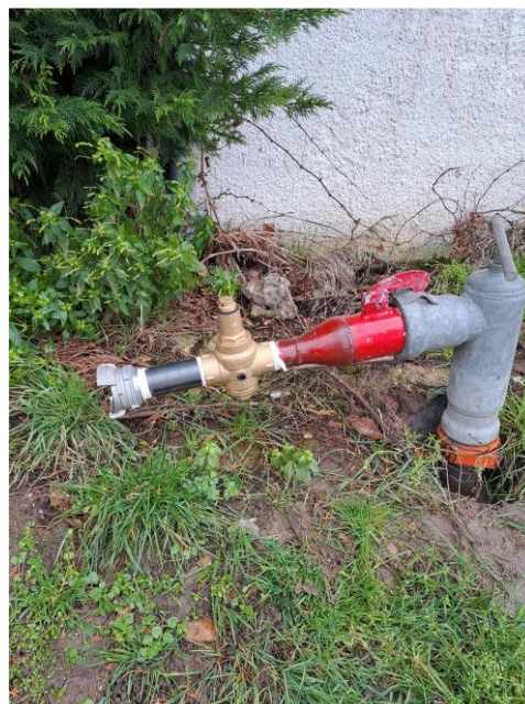
Forage avec demi-raccord 65 mm
